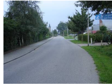
De begeleiding door voetpad, blokhagen en bomen langs de Waalderweg houdt op voordat men het dorp verlaat.
