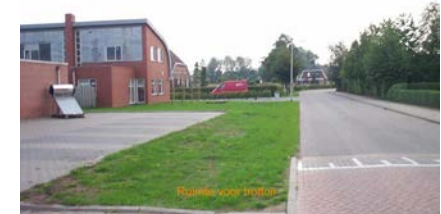
Bedrijfsbebouwing ligt er hierdoor kaal bij, in het bijzonder ook in het zicht vanaf de Beenekusteeg.
